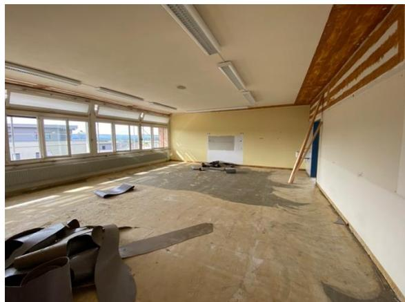
Ebenfalls wurden die Plattenbeläge und die Schadstoffkleber entfernt.
