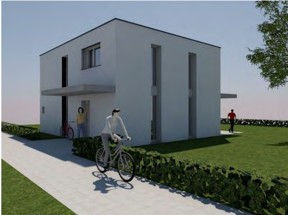
Einfamilienhaus Aussenansicht Eingangsbereich
