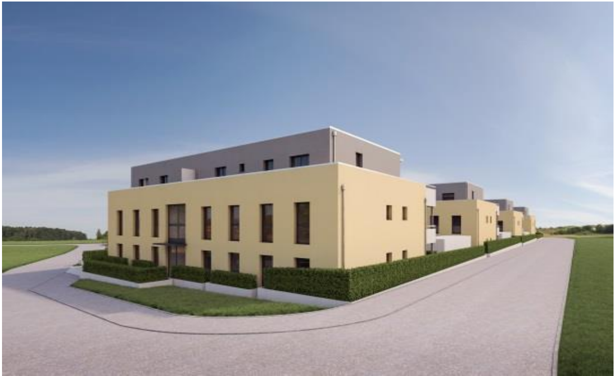
Haus D, Nordost (im Hintergrund C, B und A)
