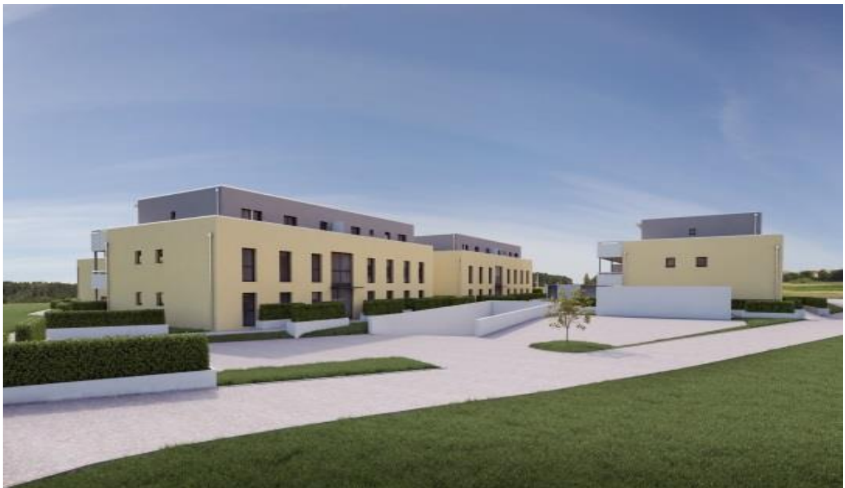
Haus C, D + E, Südost (Zufahrt)
